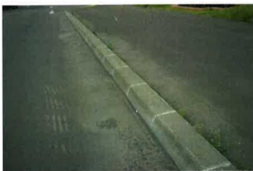
図9 寒冷地における即脱成形製品 境界ブロック 千歳市 経年10年 劣化度0
