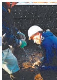
3 KCパネル固定ナットの取付け
