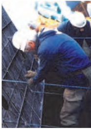
5 KCパネルの固定
