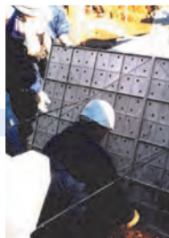
2 KCパネルの取付け
