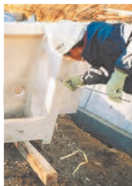
1 セパレーターの取付け
