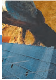
6 裏込め材料の投入
