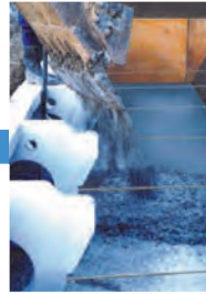
7 胴込めコンクリートの打設
