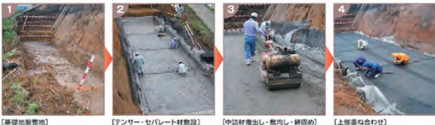
【基礎地盤整地】
