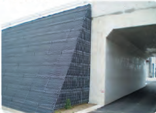
ボックスカルバート部掘り付けは直勾配
