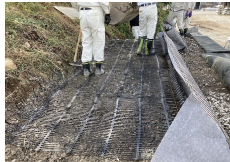
③テンサー敷設
