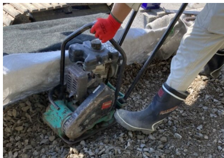
⑧鋼製枠上半分(25cm)盛土材転圧
