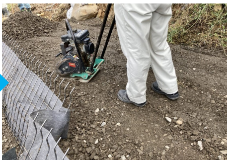
④鋼製枠下半分(25cm)盛土材転圧
