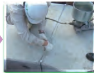
上部より頂版天端部へ注入
