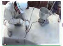
注入口より側壁部・底板部へ注入
