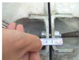
⑨目地管理 \phi 600以下 3mm \phi 800以上 5mm (目地工は不要)
