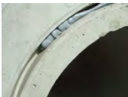
④充填は接合する両側の製品に行う
