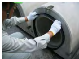
⑥ジョイントゴムの挿入
