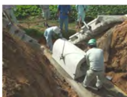
②製品据付け
