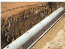
⑩施工完了
