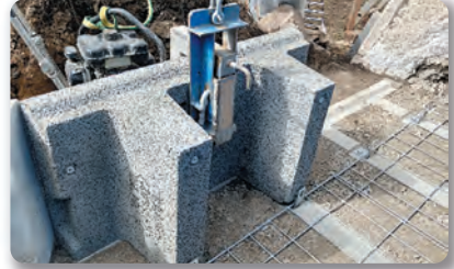
6 中詰材投入・転圧、裏込材投入・転圧
