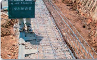
5 金具連結、背面シート設置
