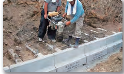
4 ポーラス(標準)ブロック据付
