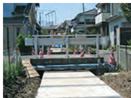
▲既設橋梁下横断
