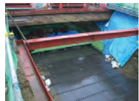
▲FCプレート設置状況
