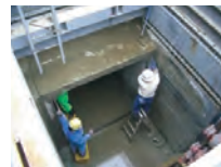
▲函体縦絡用PC鋼棒緊結状況
