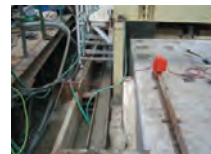
▲裏込注入状況
