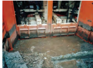
▼施工中のオープンシールド機(NOS1型)
