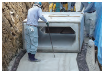
三重県 ボックスカルバート B1400×H600×L2000 W=3,950kg 人力・機械併用施工
