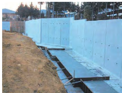
施工状況（底部部現場打ち）
