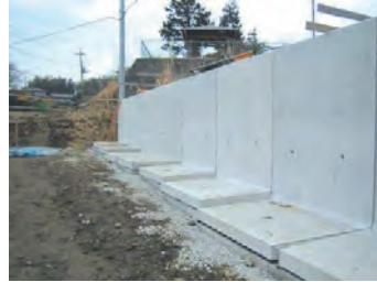
敷き段差施工
