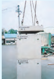
④スラブ・直壁据付
