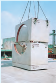
③直壁据付
