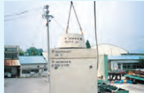
⑤円形1号斜壁据付
