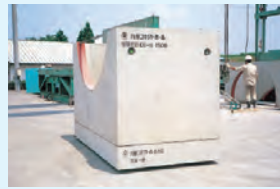
②管取付壁据付
