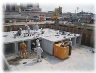
BOX 型雨水貯水槽への適用例 内幅 1200 × 内高 1200mm (ボックスどうしは耐震接続「TB(タッチボンド)工法」)
