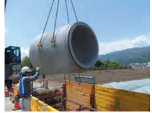
台付管吊り込み
