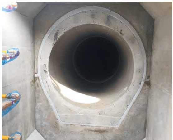
ベント・ジョイント桝内、台付管TBコーキング接続
