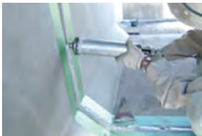
TB コーキング工法
