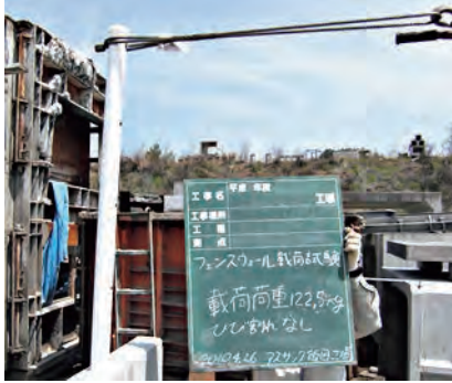
※規定荷重載荷時(支柱が先にたわんでしまう)
