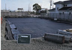
6 側部・配管部シート工
