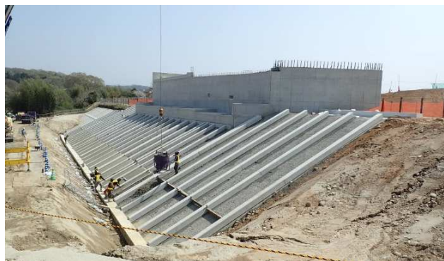
ブロック敷設後の間詰コンクリートが不要になり、養生も不要。
