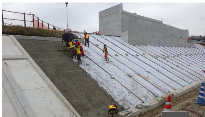
ブロック敷設前の均しコンクリートが不要、養生も不要。
