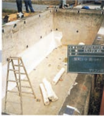
5 緩衝シート貼付
