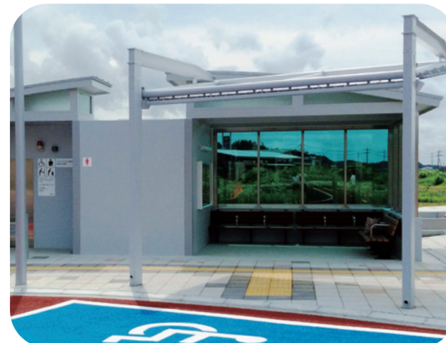
茨城県小美玉市 TB-75-60-038 前面 (マテラントイレ併設)
