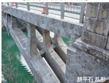
【登録有形文化財 久米路橋】
